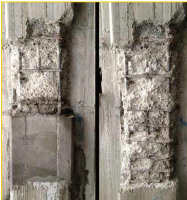
ملات تعمیراتی Vand Top Fix با جزئی آماده مصرف با مقاومت بالا، ترکیبی از کوپلیمرهای برگشت ناپذیر با خاصیت آب بند، الیاف های پلی پروپیلن برای کنترل ترک، سنگدانه های دانه بندی شده سیلیسیسی با مقاومت بالا و سایر افزودنی های می باشد. این ملات، ویژه ترمیم و تعمیرات تمامی سازه ها و المان های بتونی آسیب دیده طراحی شده است.
